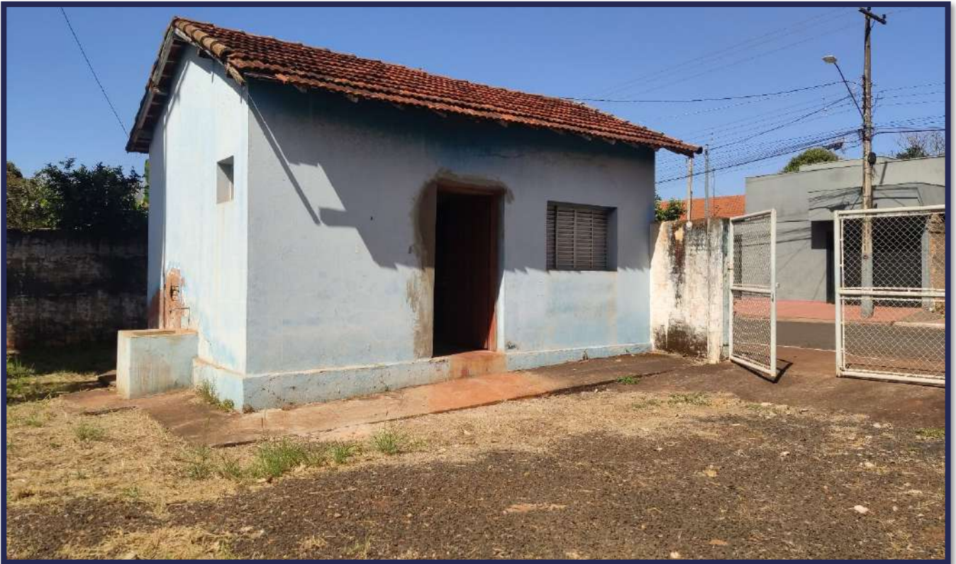
Figura 3-54 - Vista atual das instalações do Poço Pioneiros.
