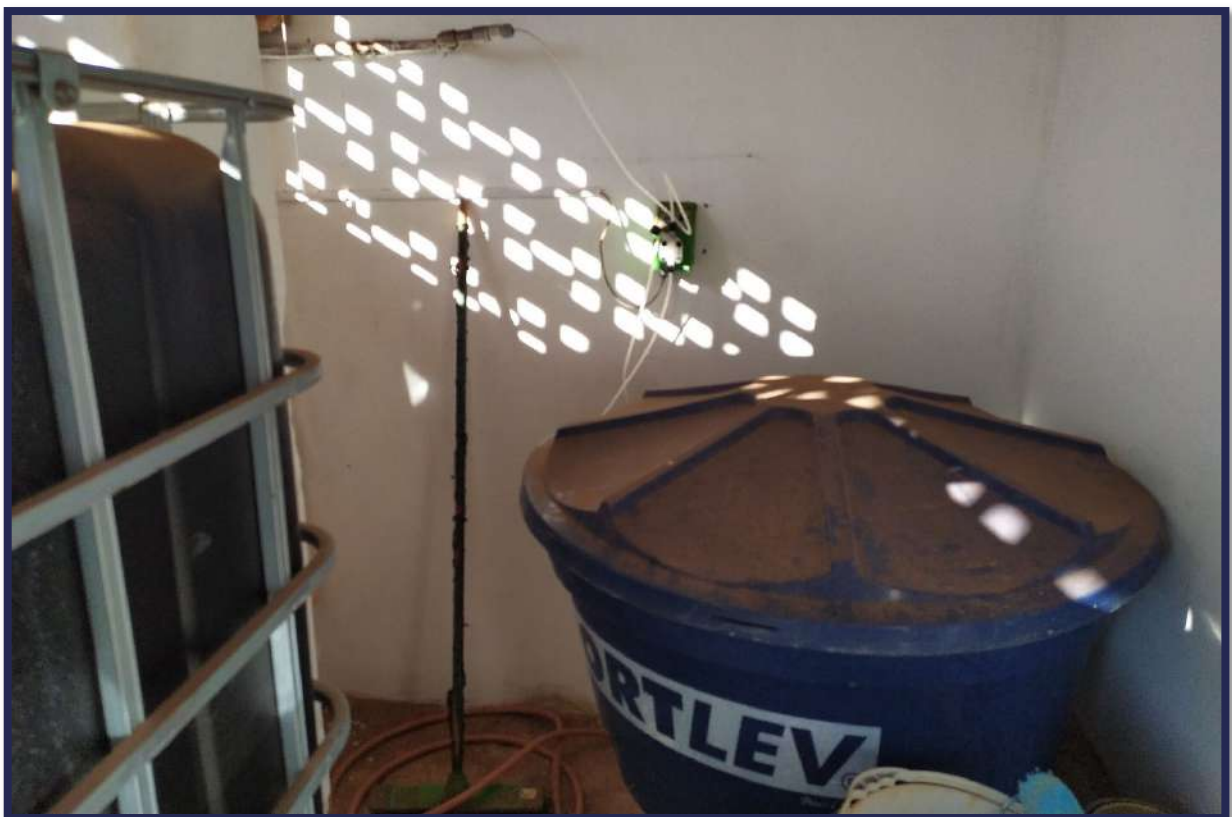
Figura 3-27 - Vista atual das instalaes do Poo 09.
