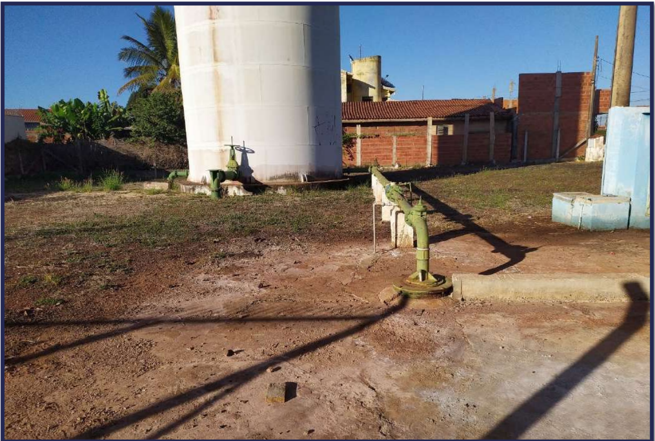
Figura 3-46 - Vista atual das instalaes do Reservatrio 06.
