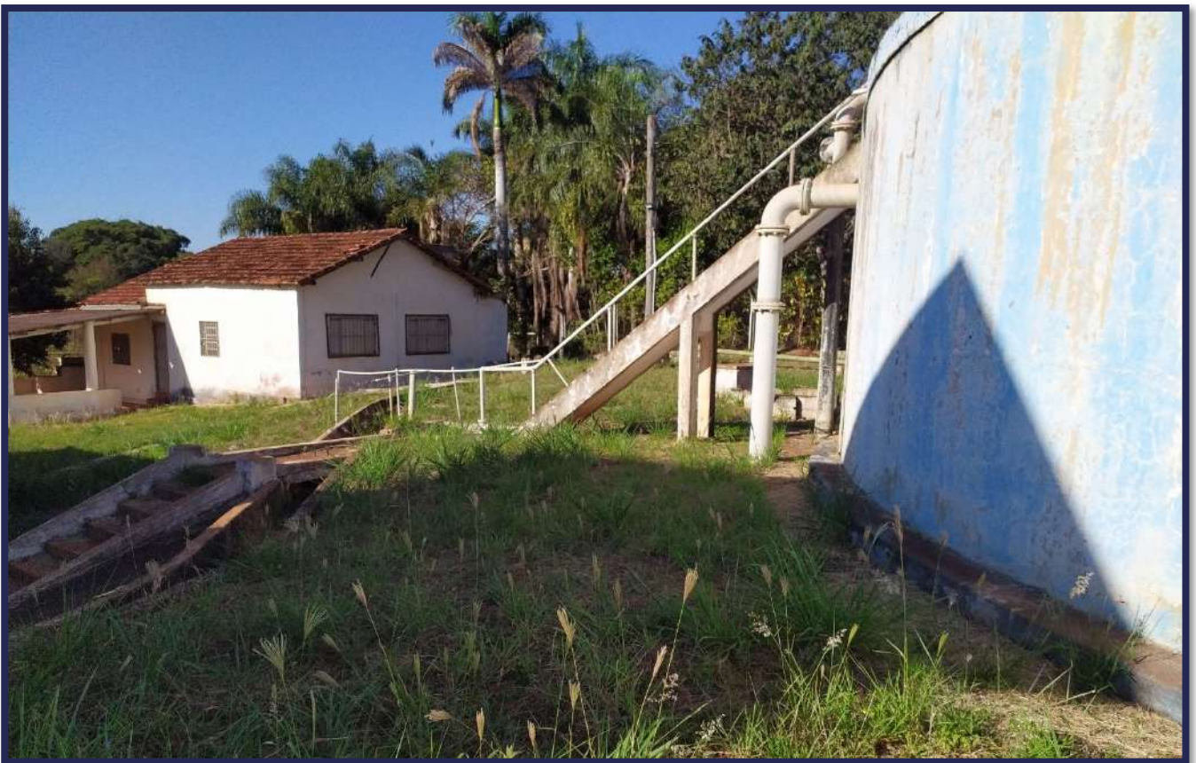
Figura 3-44 - Vista atual das instalaes do Reservatrio 03.
