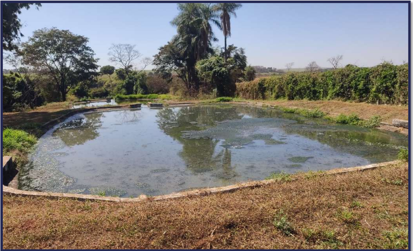
Figura 4-27 - Vista atual das instalações da ETE Pioneiros.
