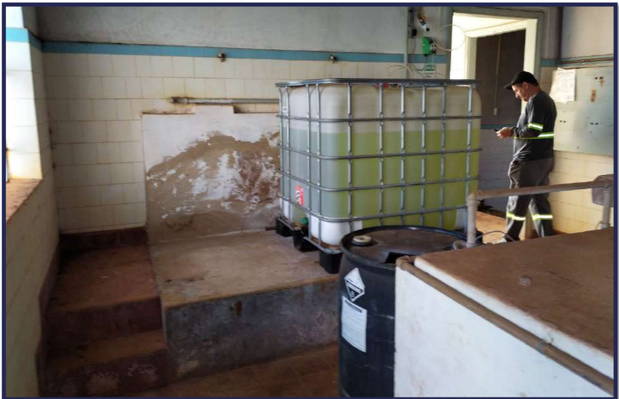
Figura 3-21 - Vista atual das instalaes do Poo 03.
