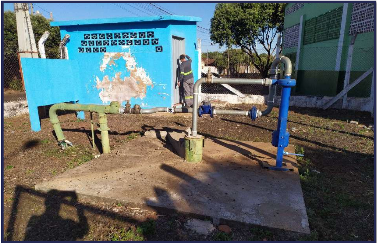
Figura 3-26 - Vista atual das instalaes do Poo 09.
