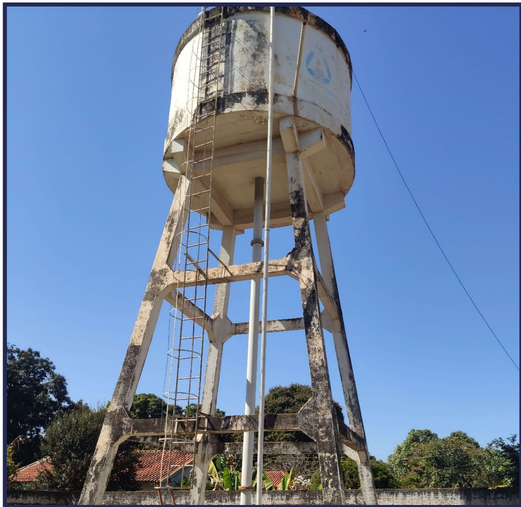
Figura 3-63 - Vista atual das instalaes do Reservatrio Pioneiros.
