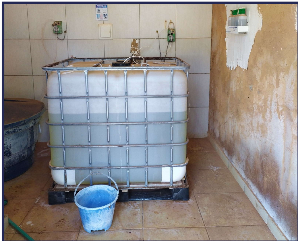
Figura 3-18 - Vista atual das instalaes do Poo 10.
