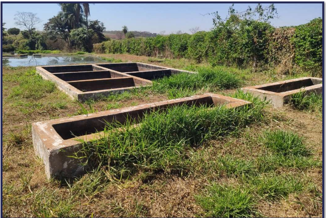
Figura 4-26 - Vista atual das instalações da ETE Pioneiros.
