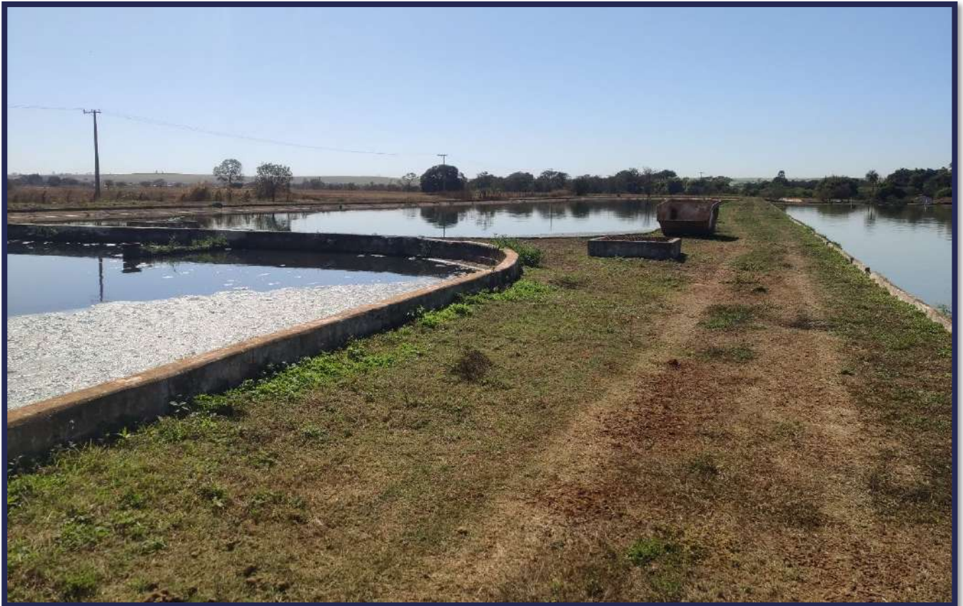
Figura 4-19 - Vista atual das instalações da ETE Vacariú.
