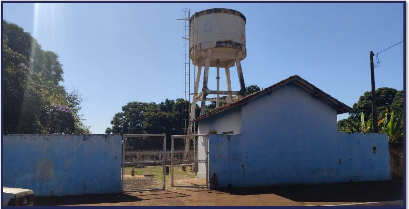
Figura 3-62 - Vista atual das instalaes do Reservatrio Pioneiros.
