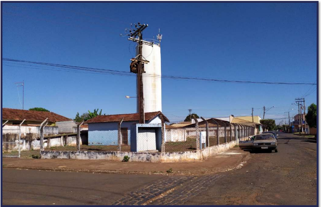
Figura 3-40 - Vista atual das instalaes do Reservatrio 02.
