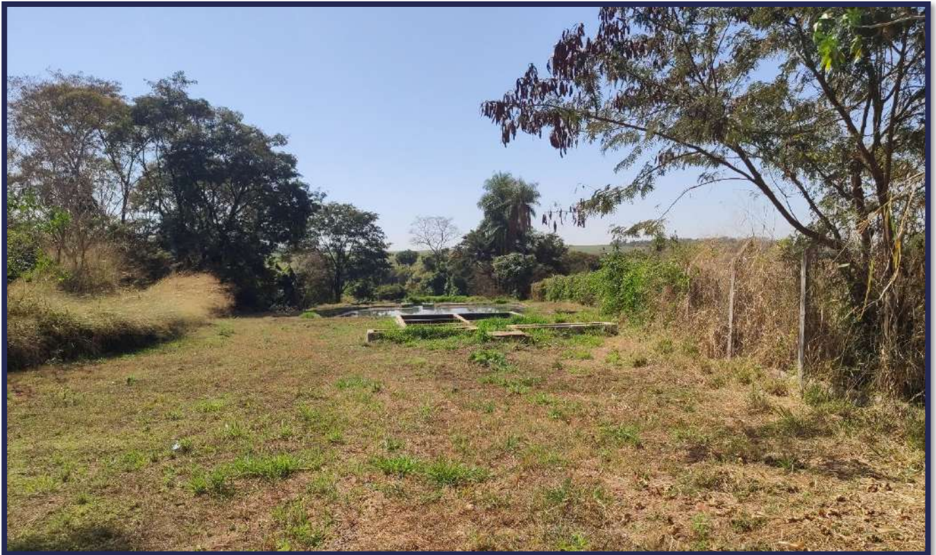
Figura 4-25 - Vista atual das instalações da ETE Pioneiros.
