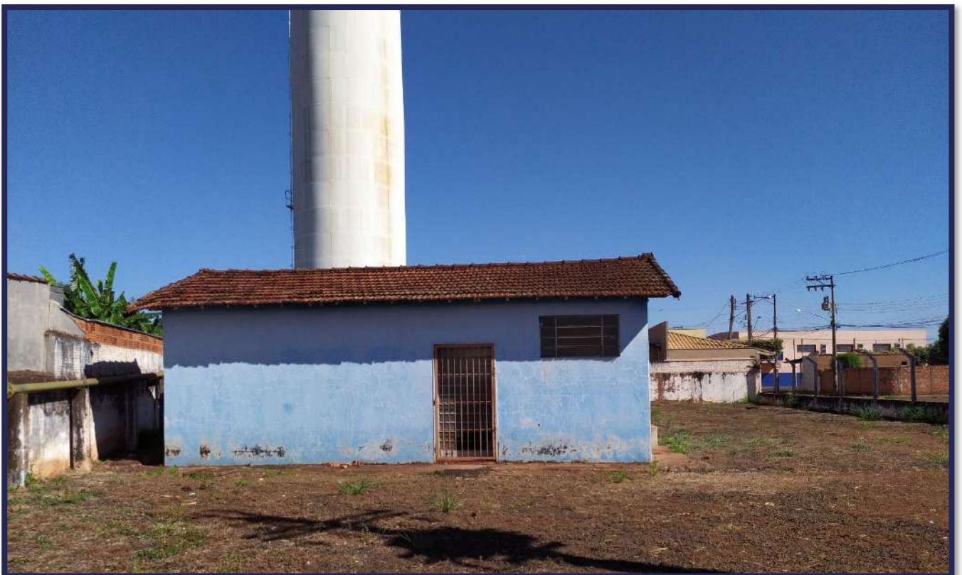
Figura 3-41 - Vista atual das instalaes do Reservatrio 02.
