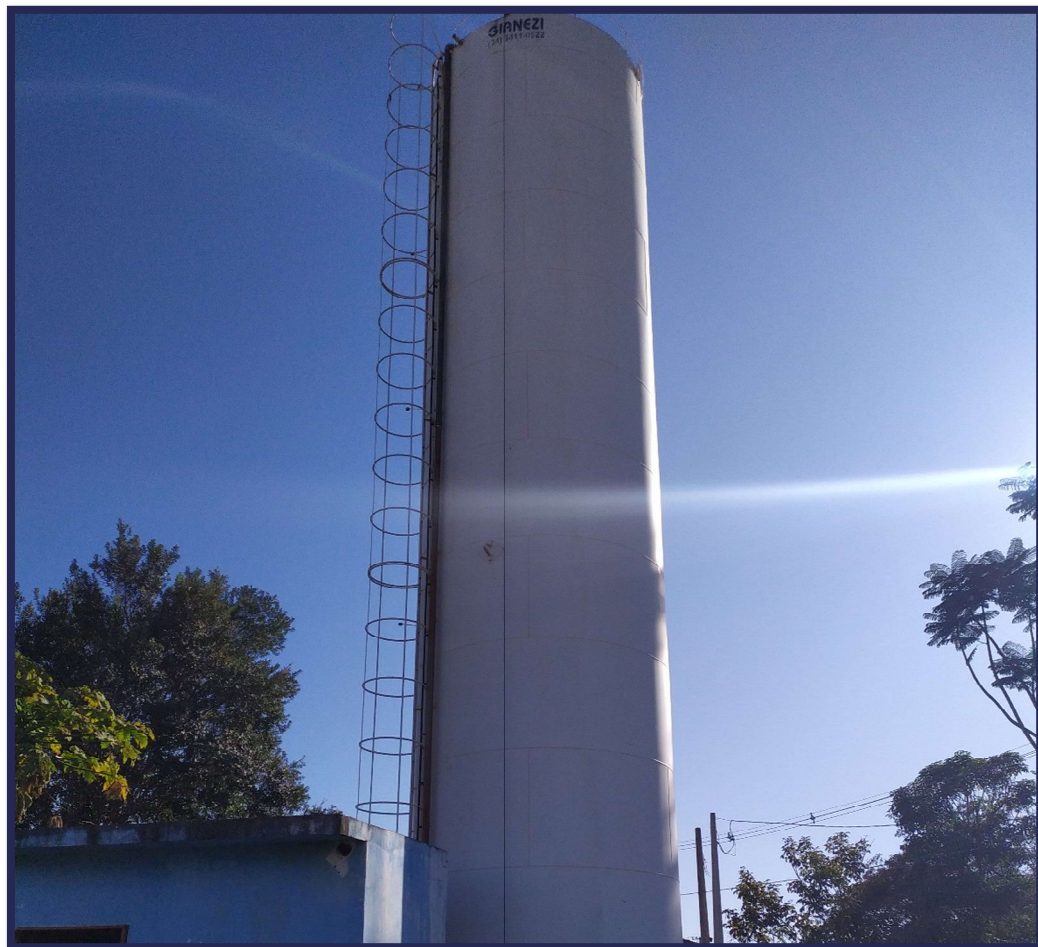
Figura 3-49 - Vista atual das instalaes do Reservatrio 12.
