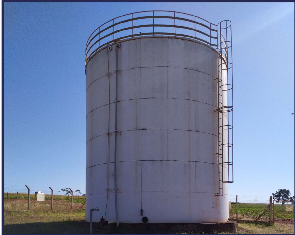
Figura 3-38 - Vista atual das instalaes do Reservatrio 11.
