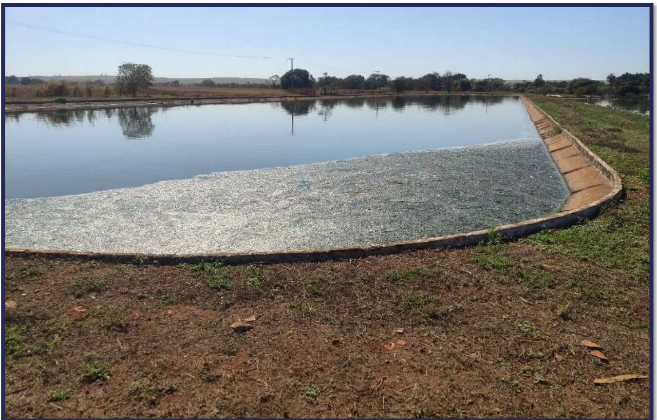
Figura 4-20 - Vista atual das instalações da ETE Vacariú.
