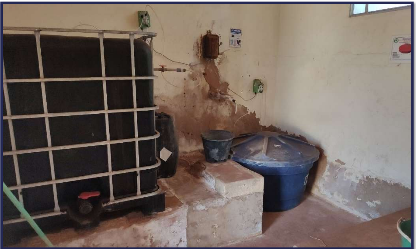
Figura 3-55 - Vista atual das instalações do Poço Pioneiros.
