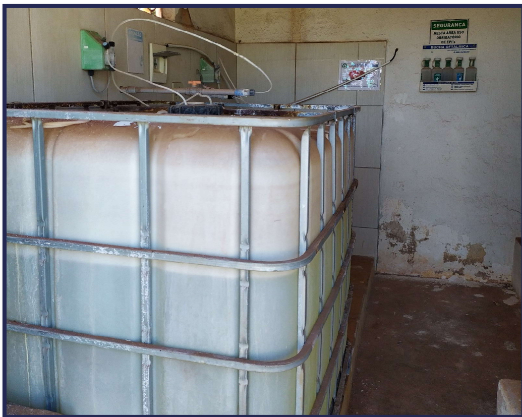
Figura 3-15 - Vista atual das instalaes do Poo 08.
