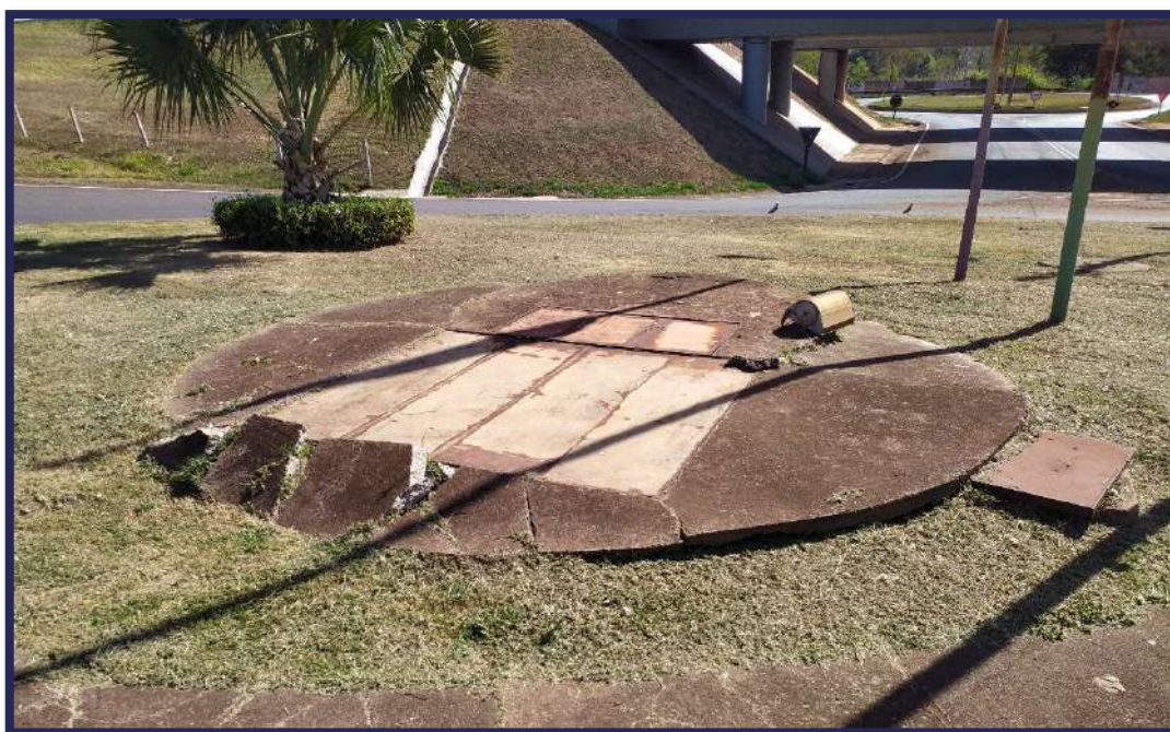
Figura 4-11 - Vista atual das instalaes da EEE 15 de Setembro.
