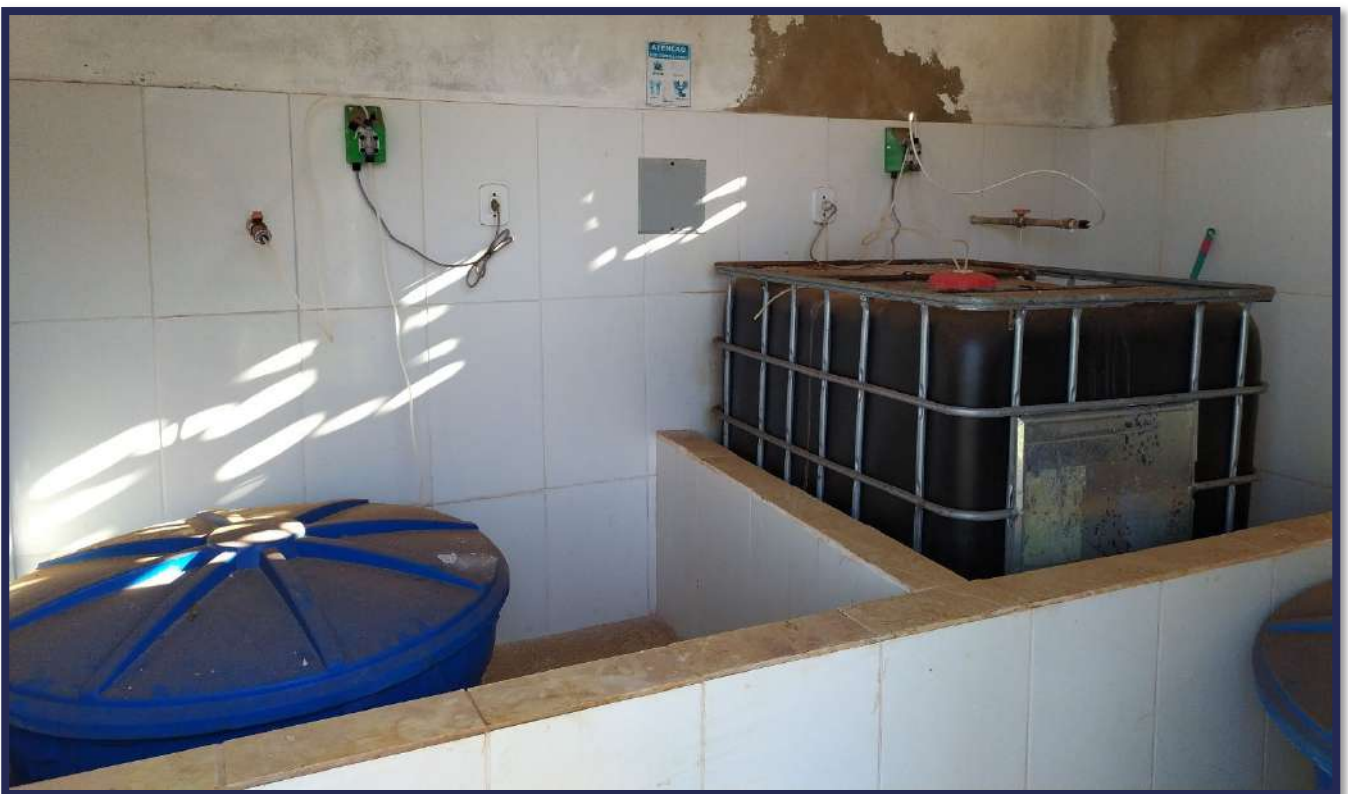
Figura 3-30 - Vista atual das instalaes do Poo 12.
